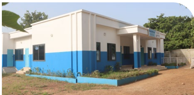
Vue latérale de l'espace sûr construit à Bantè, au Bénin
